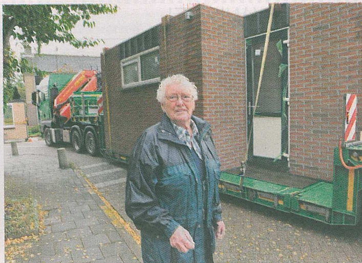
De berging, eveneens geheel geprefabriceerd, arriveert ter plaatse om 09.42 uur (boven). Om 10.12 uur wordt deze in één keer op de bestaande fundering geplaatst. Foto's: Martin Mooij
