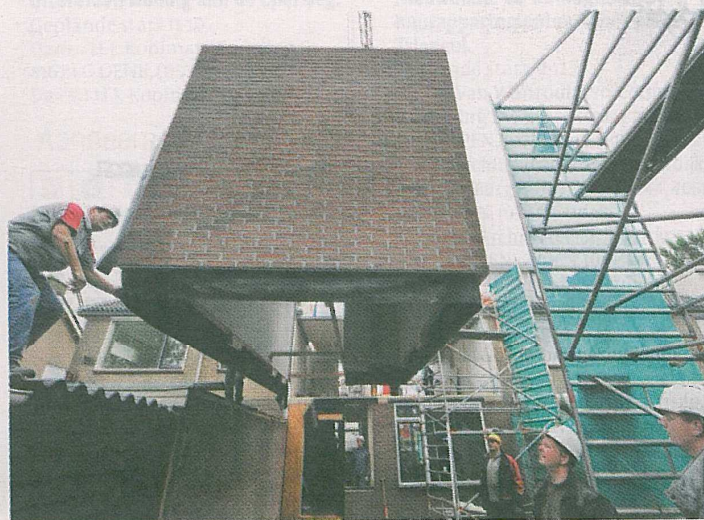
De berging, eveneens geheel geprefabriceerd, arriveert ter plaatse om 09.42 uur (boven). Om 10.12 uur wordt deze in één keer op de bestaande fundering geplaatst. Foto's: Martin Mooij
