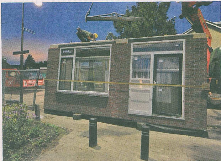
De voorgevel, inclusief kozijnen, ramen en deur, komt om 06.30 uur aan op de bouwlocatie in Eersum (boven). Om 09.17 uur kan de gevel in de in de gestripte voorgevel van de bestaande woning worden geschoven (onder).
