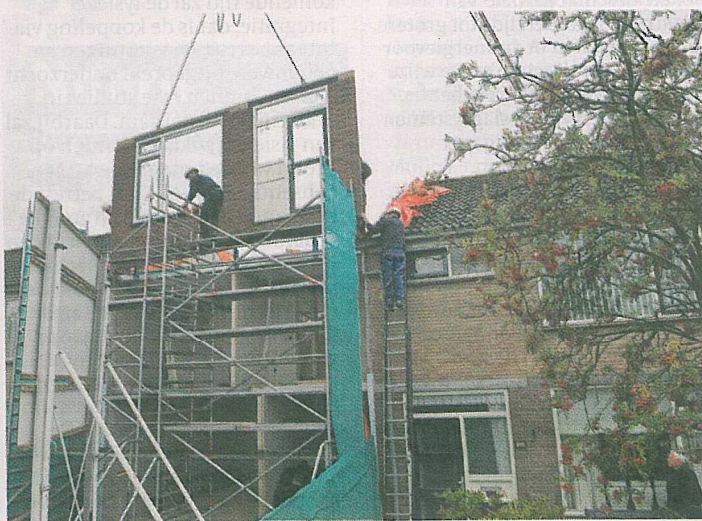
De voorgevel, inclusief kozijnen, ramen en deur, komt om 06.30 uur aan op de bouwlocatie in Eersum (boven). Om 09.17 uur kan de gevel in de in de gestripte voorgevel van de bestaande woning worden geschoven (onder).
